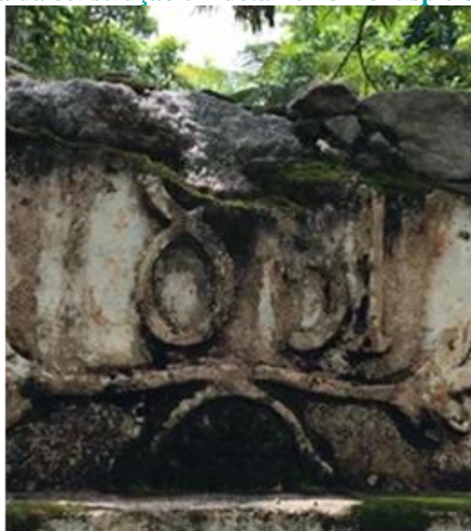
Figura 3: Data da construção em detalhe no frontispício da construção
