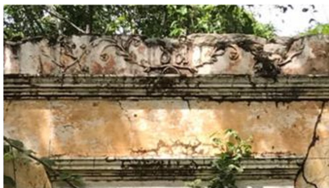
Figura 7: Ramos da fachada
