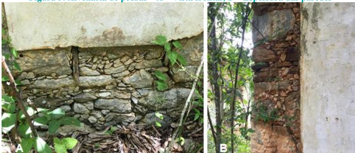
Figura 5: Alvenaria de pedras – A – Vista frontal; B – Espessura das paredes
