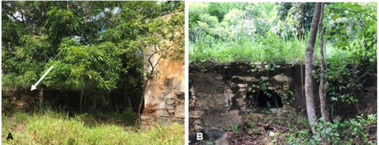
Figura 14: Terreiro de café – A – Vista; B – Detalhe da alvenaria
