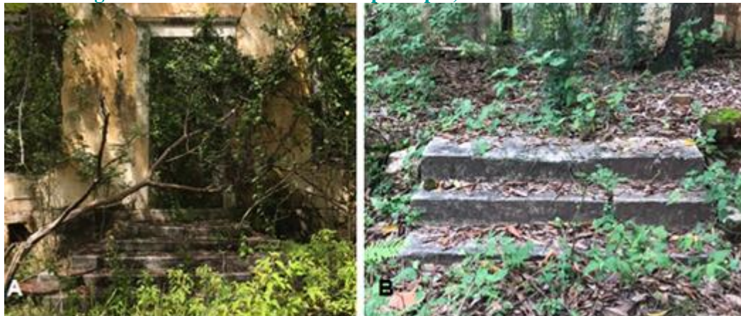
Figura 9: Escadas – A – Entrada principal; B – Entrada da varanda
