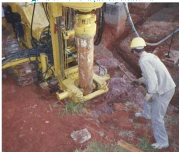
Figura 6: Perfuração da estaca raiz
