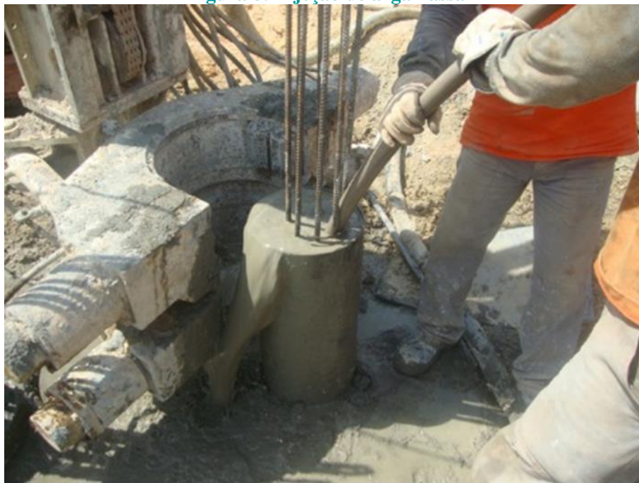
Figura 8: Injeção de argamassa
