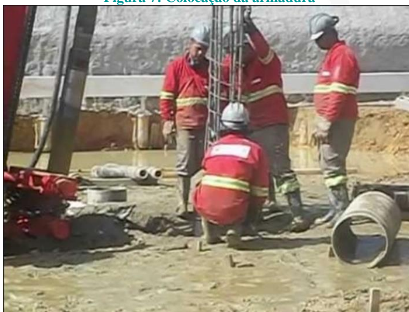
Figura 7: Colocação da armadura
