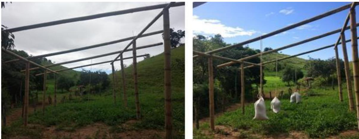
**Figura 10:** Estrutura principal montada. À direita com aplicação de carregamento.
