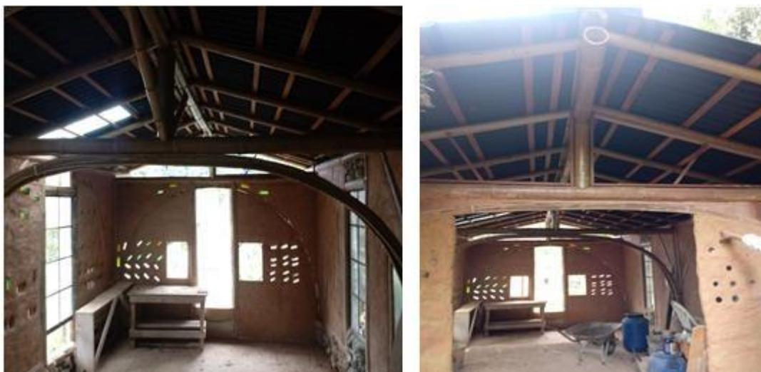
**Figura 5:** Construção desenvolvida com estrutura de Bambu Gigante.
