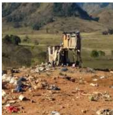
Figura 02 - Moradia precária de catadores que residem no aterro de Itaperuna-RJ.
