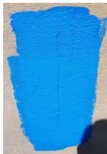
Figura 13 – 1ª de mão de tinta acrílica em uma parede com revestimento e ranhuras.
