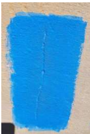
Figura 12 – 1ª de mão de tinta caseira em uma parede com revestimento e ranhuras.
