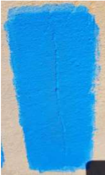
Figura 14 – 2ª de mão de tinta caseira em uma parede com revestimento e ranhuras.
