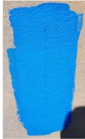
Figura 15 – 2ª de mão de tinta acrílica em uma parede com revestimento e ranhuras.
