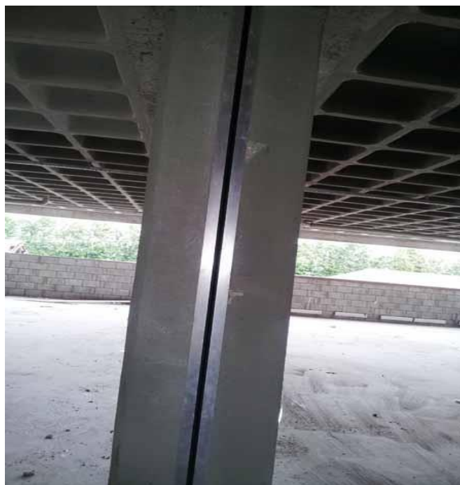
Figura 3: Juntas de dilatação vertical
