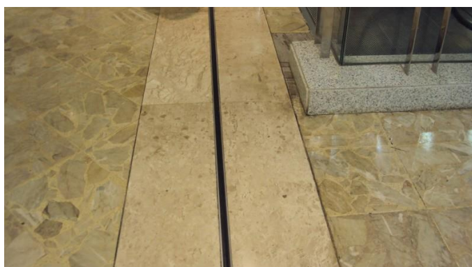
Figura 2: Juntas de dilatação horizontal
