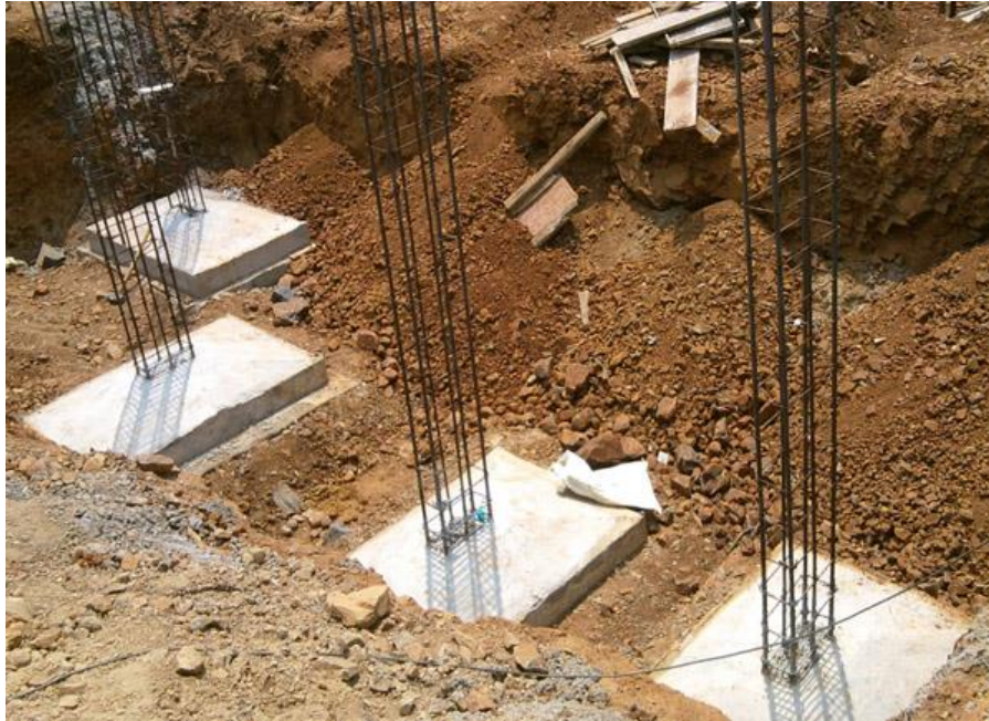
Figura 1: Construção de sapata rasa. Fonte: Escola Engenharia, online .
